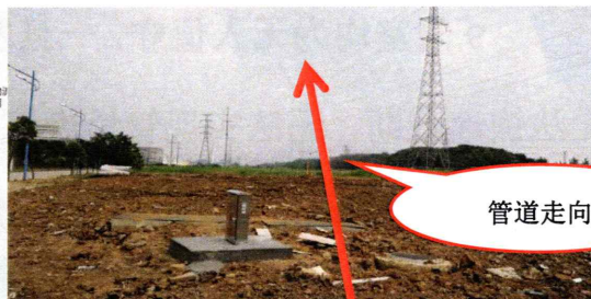
第三方施工无管控措施，无标识警示
