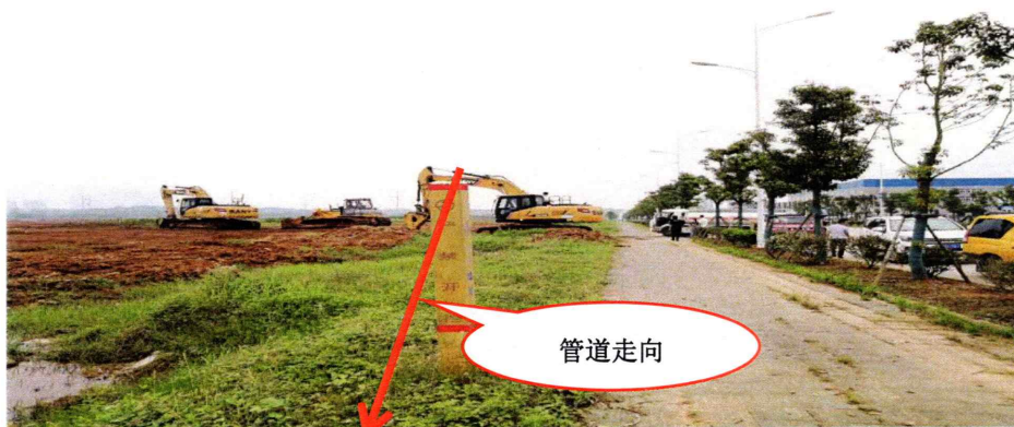
大型挖掘停在管道正上方，现场无管控措施及看护人员
