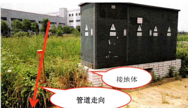
高压电力设施接地体和基础位于管道左侧 0.8 米
