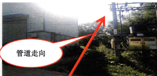
高压电力设施位于管道右侧 2 米左右
