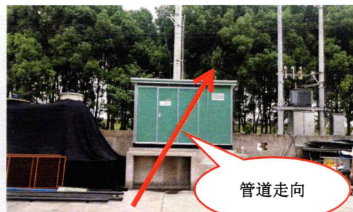
高压电力设施位于管道正上方
