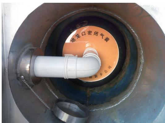
地笼口密闭隔热气囊使用图
